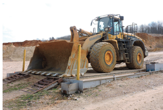
Aire étanche sur laquelle le ravitaillement en carburant et l'entretien courant des engins seront réalisés.
